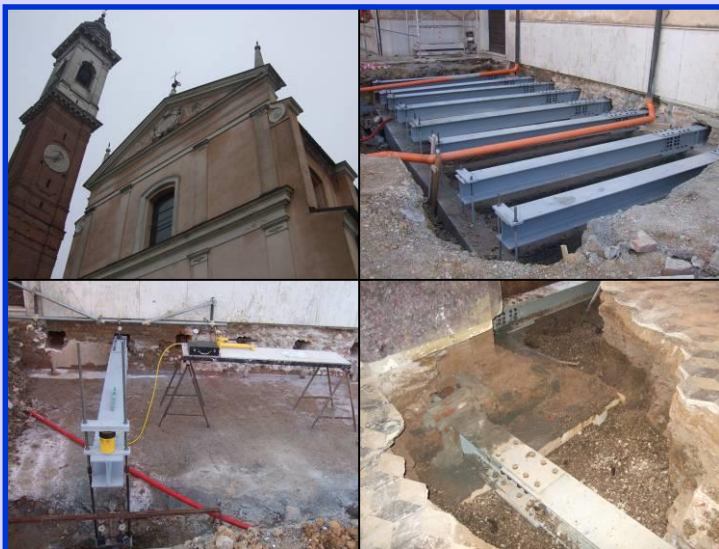
PARROCCHIA DI CAPRIANO DEL COLLE (BS) - anno 2009 - Opere di consolidamento strutturale alla Chiesa di S. Michele Arcangelo.
