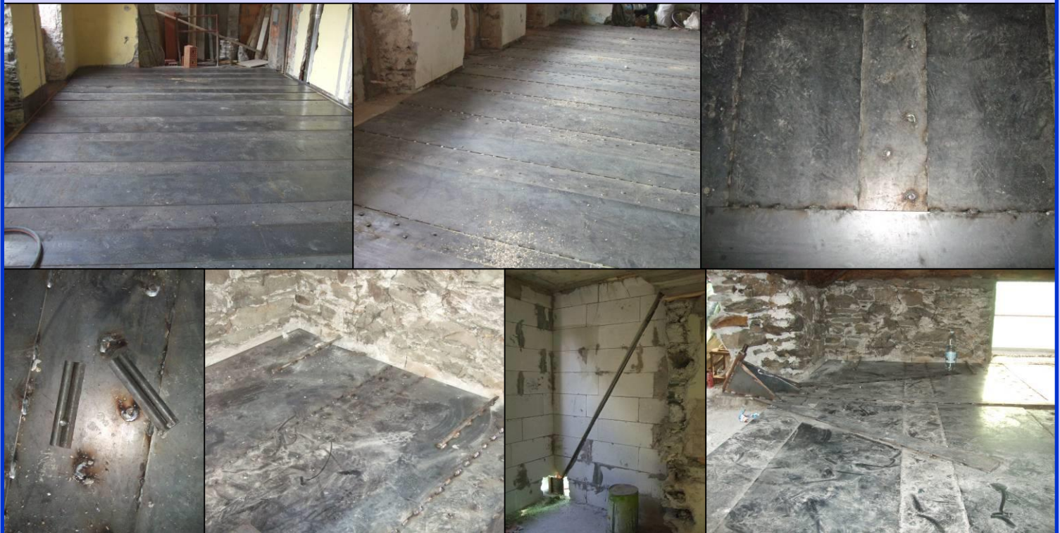
CASA PRIVATA A CORTENO (BS) - anno 2009 - Consolidamento impalcati in legno tramite lamiere metalliche dello spessore di 5 mm connesse alle sottostanti travi lignee con spinotti metallici, carotaggi e posa catene metalliche, realizzazione ancoraggio del nuovo corpo aggiunto.
