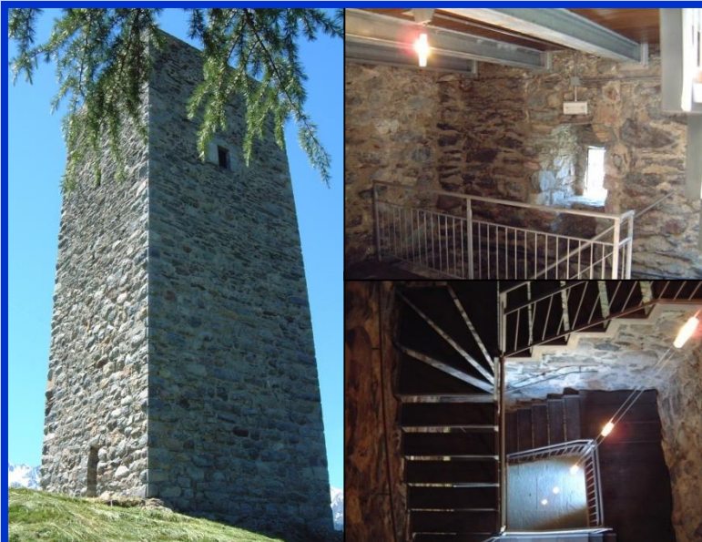
TORRE DI TEGLIO (SO) - anno 2000 - Lavori di restauro e consolidamento statico alla Torre "de li beli miri" immersa nel verde della sua pineta e situata sul dosso a sud del paese in posizione dominante sulla Valtellina e simbolo stesso del paese; poggia su un naturale basamento di roccia, ha pianta quadrata ed è costituita nella parte inferiore da grossi massi le cui dimensioni diminuiscono procedendo verso l'alto.
