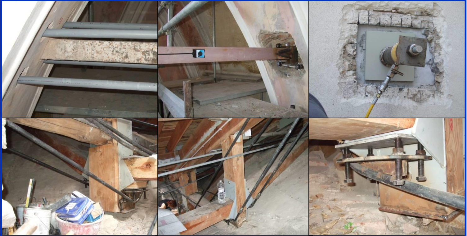
PARROCCHIA DI PRESEGLIE (BS) - anno 2007/8 - Opere di consolidamento strutturale alla Chiesa dei Santi Pietro e Paolo tramite posa di catene e tiranti metallici in seguito al terremoto del 2004.
