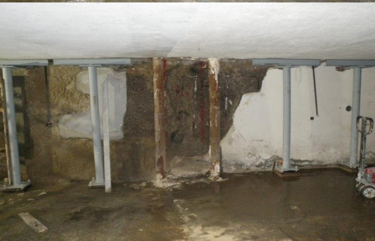
CONDOMINIO SAN MARTINO a Manerbio (BS) – anno 2012 – Intervento di rinforzo strutturale tramite la realizzazione di micropali in acciaio.
