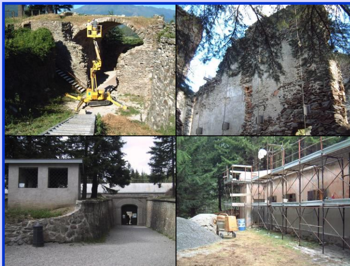
FORTE FUENTES di COLICO (LC) - anno 1998 - Lavori di consolidamento, restauro e manutenzione per conto della Provincia di Lecco.
