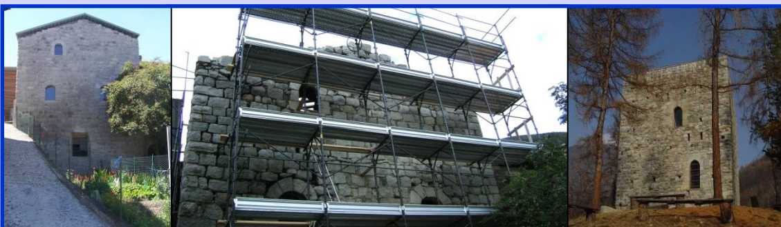
VEZZA D'OGGIO (BS) - anno 2006 - Consolidamento della Torre Federici, alta quindici metri, rastremata alla base, costruita in pietra viva, lavorata con conci irregolari.
