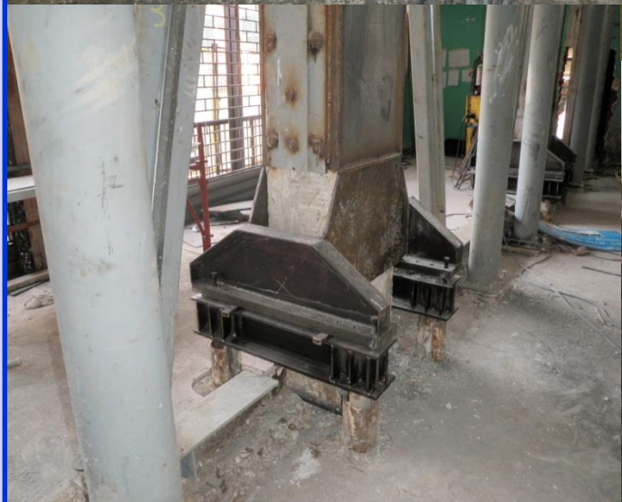
CONDOMINIO SAN MARTINO a Manerbio (BS) – anno 2012 – Intervento di rinforzo strutturale tramite la realizzazione di micropali in acciaio.
